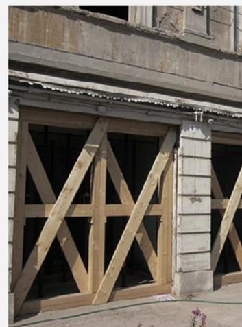
**CONTROVENTATURA.** Esempio di controventatura delle aperture.
