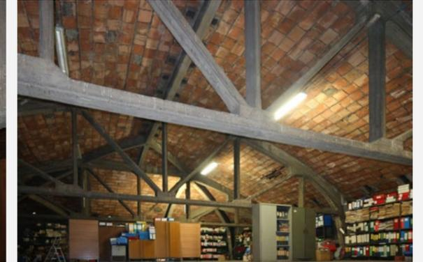
CAPRIATE. È prevista l'impermeabilizzazione e il rafforzamento della capacità ignifuga di elementi costruttivi esistenti.
