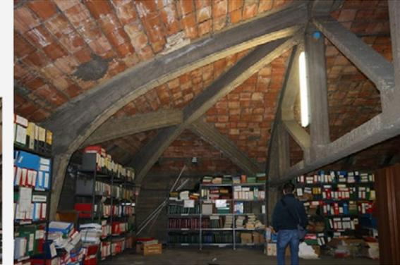
COPERTURE. Fotografia dello stato attuale del soffitto laterizi con archi prefabbricati in calcestruzzo.
