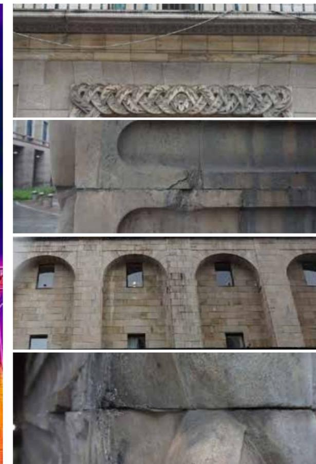
Particolari di alterazioni e degradazioni del paramento esterno
