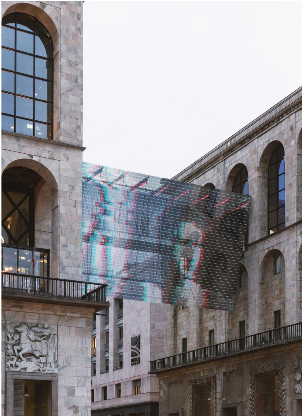
Museo del Novecento. La passerella di collegamento è costituita da un elemento a sezione rettangolare strutturalmente indipendente realizzato in carpenteria metallica e vetro. A questa struttura è appesa una facciata in vetro a geometria triangolare con tecnologia LED integrata che può fungere da schermo per proiezioni ed installazioni site-specific.
